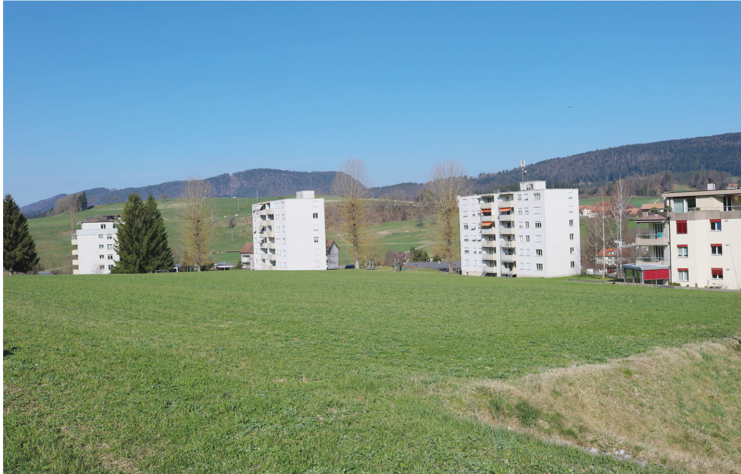
Le secteur ensoleillé des «Grands Champs» se situe à côté de l'entreprise Pierval, du côté Montoz et à l'entrée du village en venant de Tavannes. BASSIN
